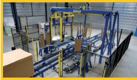
Clôtures de sécurité Safety perimeter fencing
